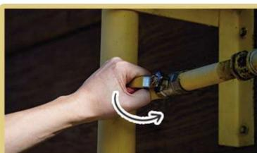
Fechar as válvulas dos equipamentos antes da entrada do regulador de pressão, a fim de facilitar o rearme do dispositivo.
